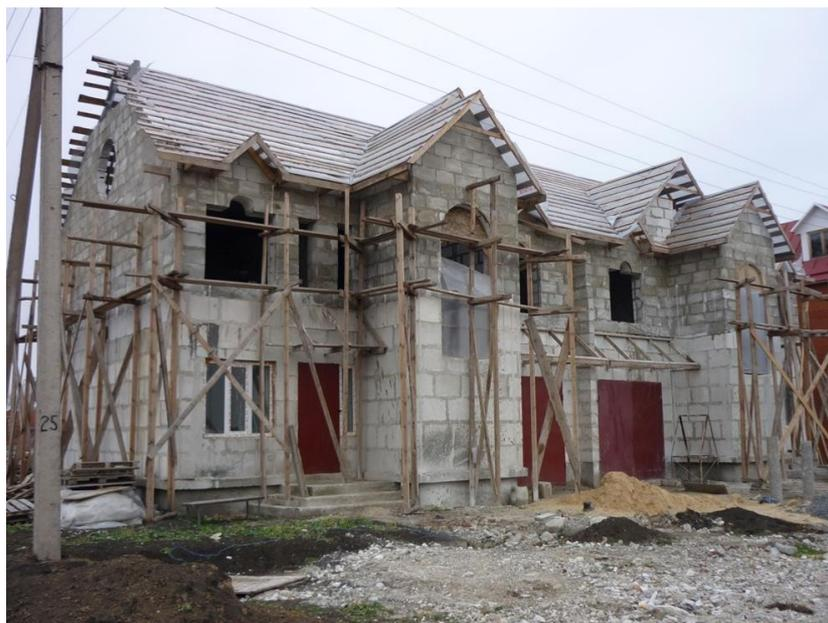
Рис. 2. Строительство коттеджа ПГП фиброгипсопенобетона
