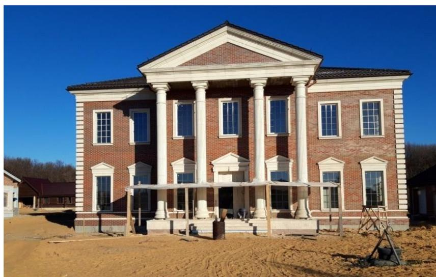
Рис. 3. Жилой дом, построенный с использованием ПГБ и теплоизоляционного фиброгипсопенобетона
